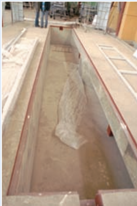
Индустриальная ОСК монтируется на прямке, а достаточная жесткость конструкции обеспечивается мощным каркасом.
