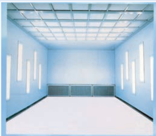
Особое внимание разработчики уделили освещенности внутри кабины. Как вариант предлагается вертикальное расположение светильников (ОСК с диагональным потоком).
