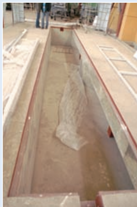
Пол ОСК для крупнотоннажной техники — серьезное инженерное сооружение.
